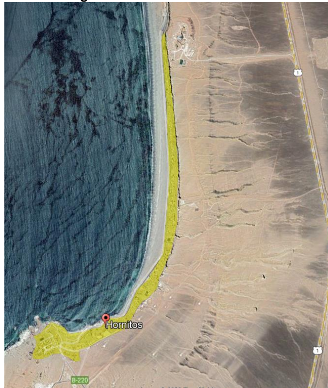
Figura 16. Localidad de Hornitos
